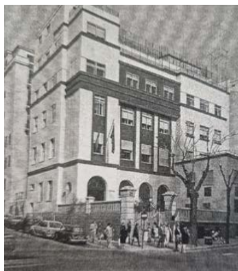
Ubicación del Instituto de Cardiología de Madrid, situado en la calle Buen Suceso.
